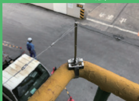
ワイヤー工法
