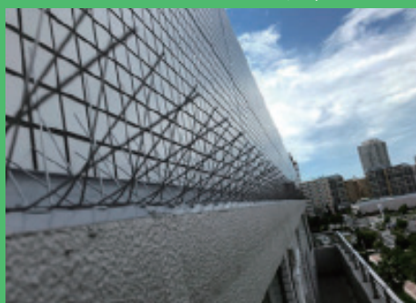
スパイク工法
